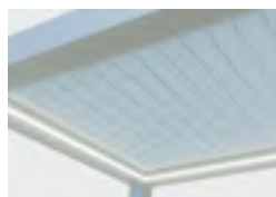
LED dans les poutres périphériques
